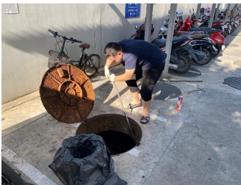
ภาพที่ 2-15 ทำความสะอาดบ่อดักไขมัน
