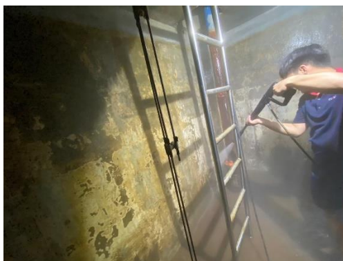
ภาพที่ 2-22 (ต่อ) การทำความสะอาดถังเก็บน้ำใต้ดินและตรวจสอบการรั่วไหล
